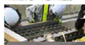
主桁ボルト接手部もノロ漏れなし
